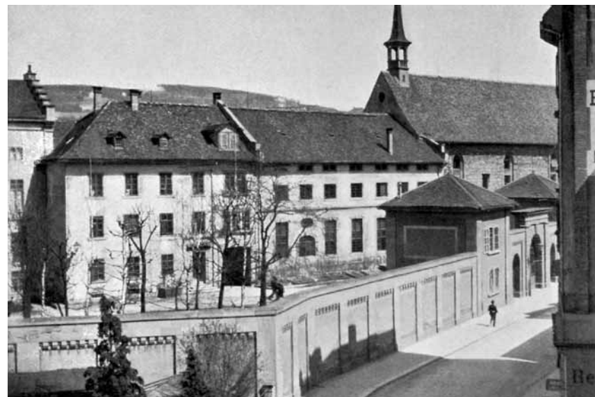
Die alte Strafanstalt im Oetenbach.
