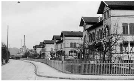
Angestelltenhäuser an der Watterstrasse
